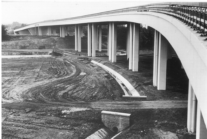
Figure 1.3 – Profil en long disgracieux (photo SETRA).
