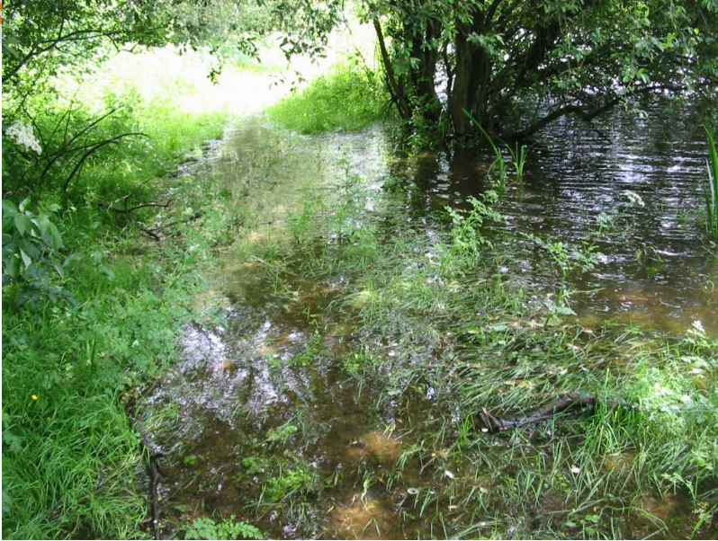
Barrage visité par Police de l'eau en mai 2007 en surverse
