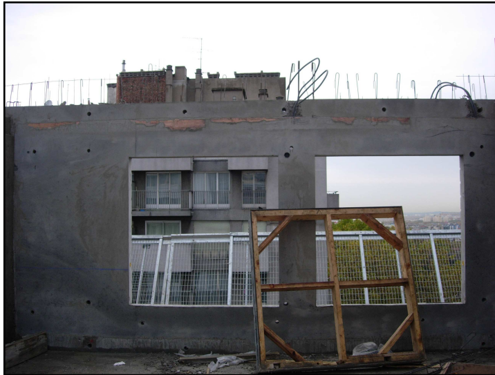
Construction du 2 ème étage
