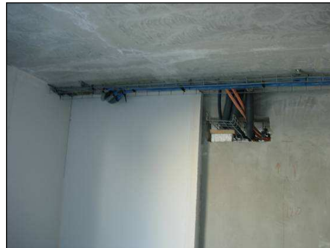
Dévoiement de la gaine au 4 ème étage
