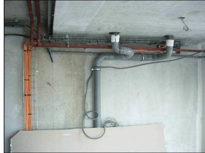
Dévoiement de la gaine au 4 ème étage
