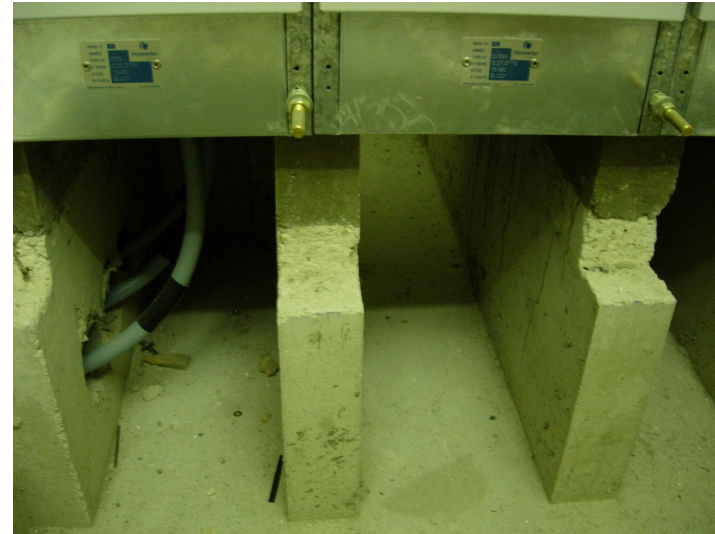
Pose et raccordement des cellules H.T.A
