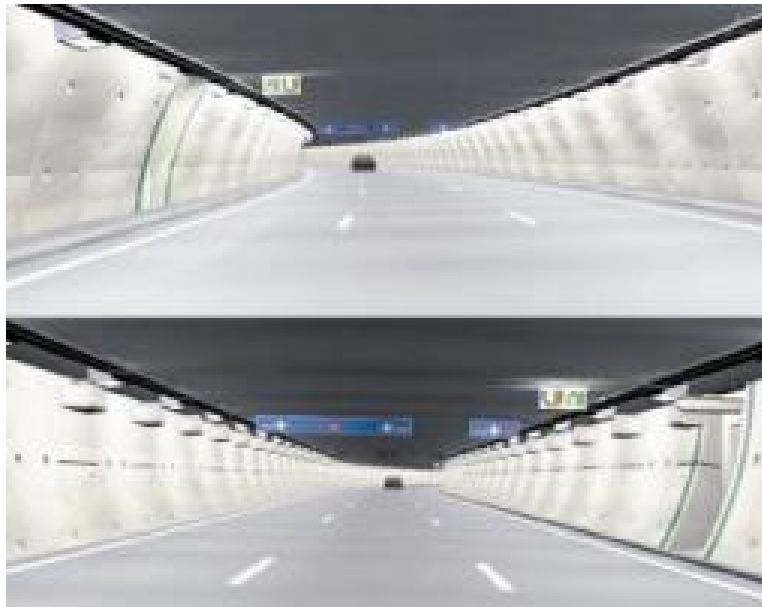
Fig. 5 : Tunnel routier urbain
