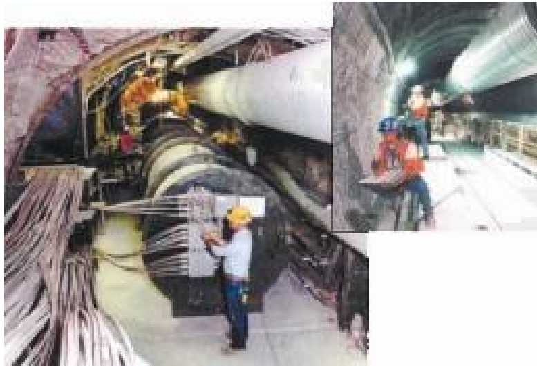
Fig. 2 : Installation d'ouvrages nucléaires
