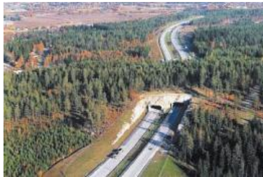
Fig. 4 : Tunnel d'autoroute formant une traversée verte
