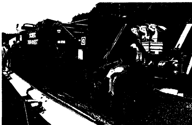
Fig. 3. — Procédé SCREG Routes « Recycold » : le fraisat tel qu'il sort de la fraiseuse. L'élévateur le reprend pour l'introduire dans une machine de malaxage-répandage sur laquelle sont ajoutées eau et émulsion (entre l'élévateur et la table, on peut distinguer la trémie de réception de fraisat et les réservoirs d'eau et d'émulsion).
