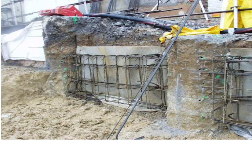
Pour cette application, le calcul béton armé est conduit en décomposant l'ouvrage en bandes horizontales correspondant au phasage du bétonnage, connectées aux éléments verticaux et sollicitées par la pression correspondant à l'épaisseur de terrain décomprimé.
