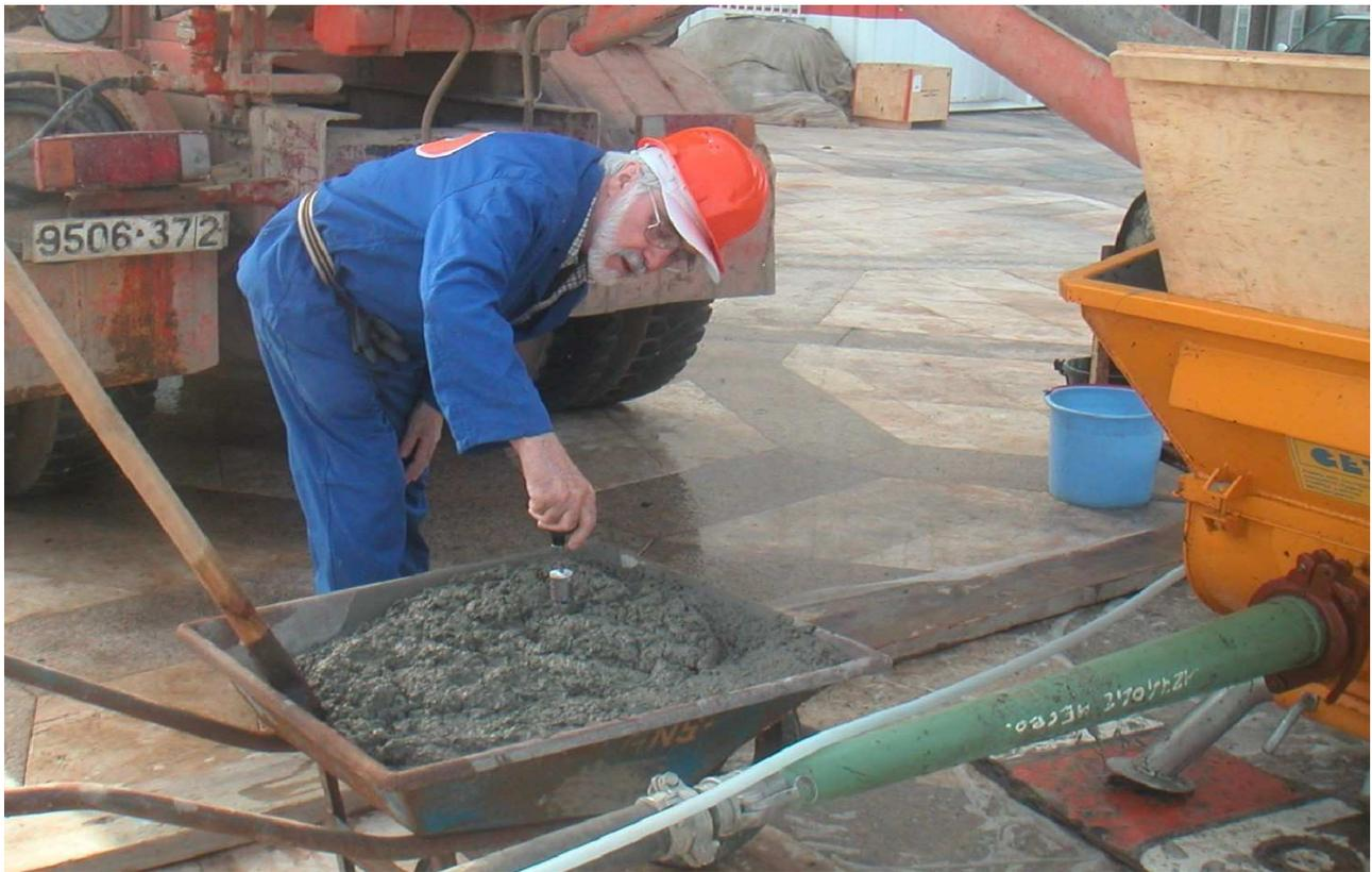
Évaluation de la pompabilité à l'aide d'un « pompabilimètre » de poche, avant de charger la pompe
