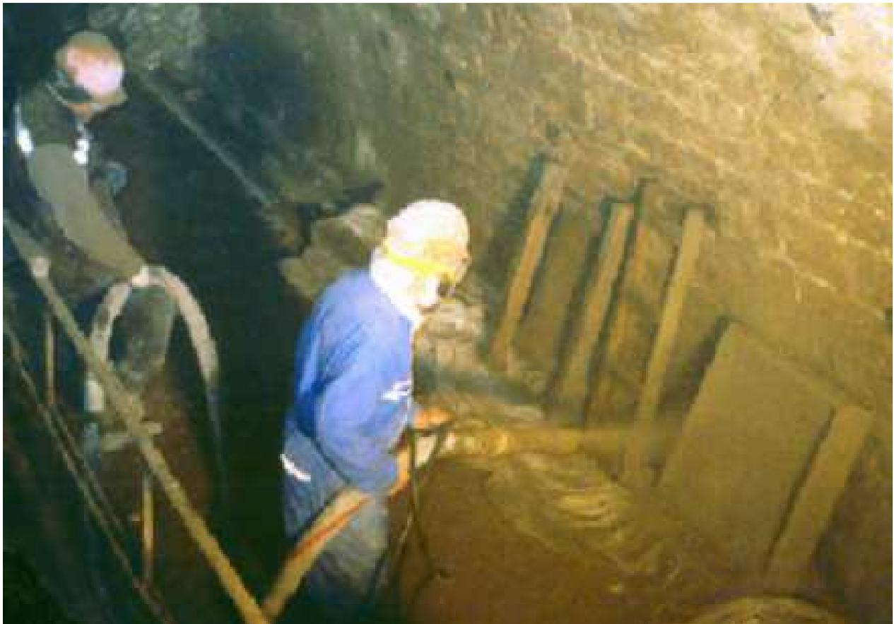
Projection (par voie sèche) dans une caisse 600 x 600 x 100 pour l'essai NF EN 14888-5 (photo VNF)
