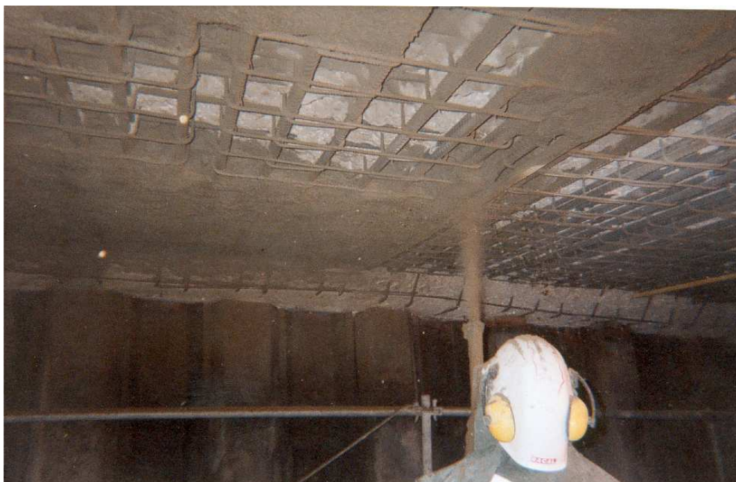
Réparation de la sous-face de la dalle du cadre après un incendie Passage inférieur du ROND -POINT BONAPARTE à TOULON Début de projection par voie sèche en plafond
