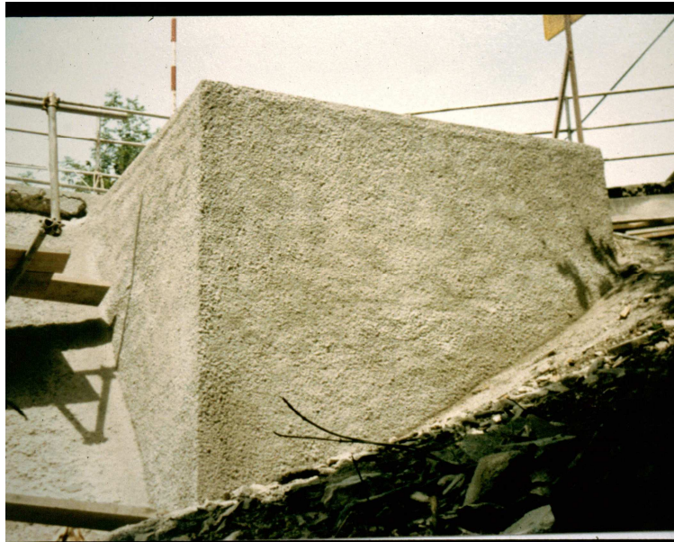
Partie d'ouvrage sur un barrage : la surface a été dressée à la règle puis une couche de fermeture (d'environ 1 cm) a été projetée pour donner un aspect de type « crépi ».
