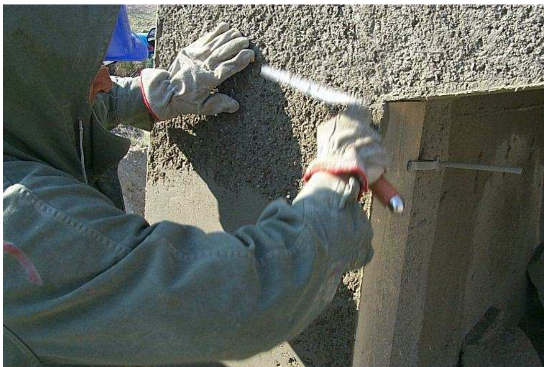
Dressement de surface par recoupe avec la tranche de la truelle
