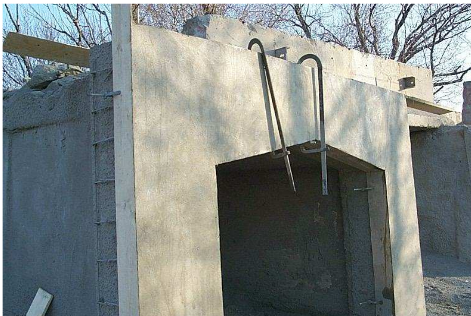
Couche de finition talochée
