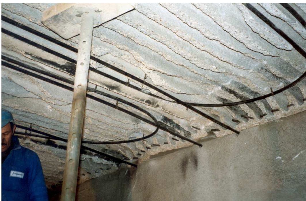
Réparation de dalles alvéolaires endommagées par un incendie
