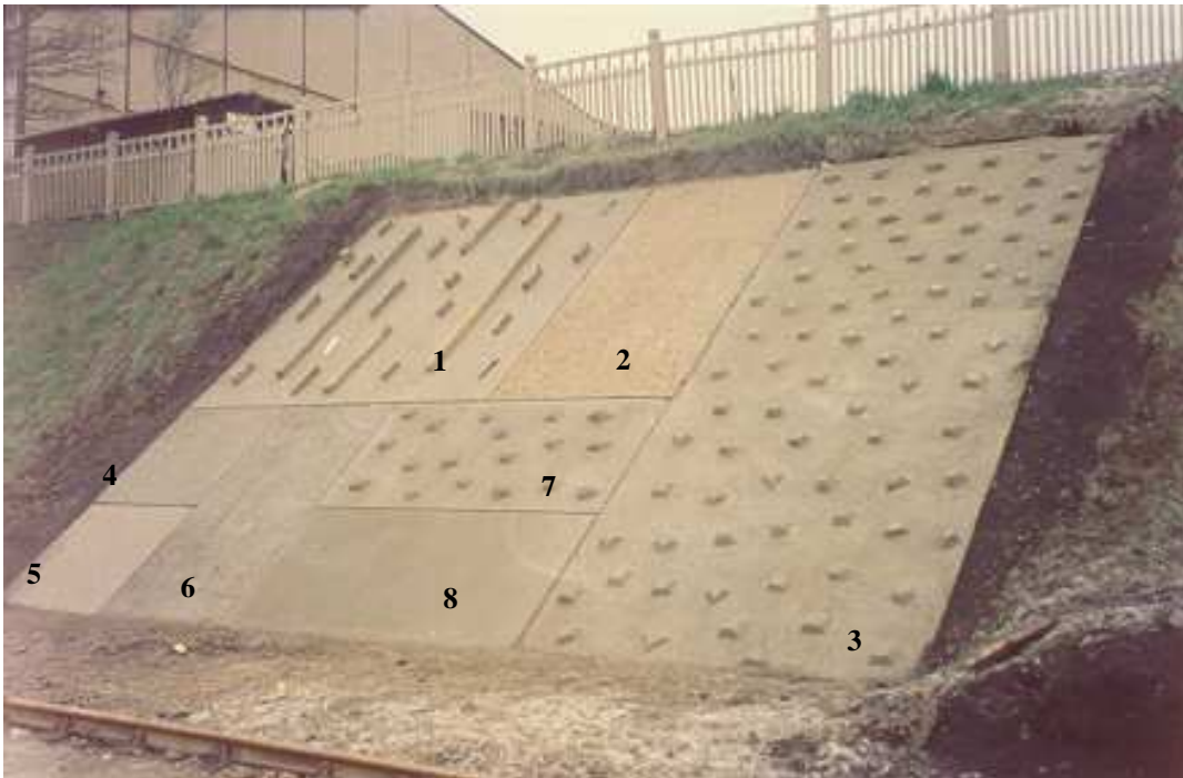
Planche d'essais pour un talus SNCF : 1, 3, 7 : plots en relief sur une surface talochée 2, 5 : béton désactivé 4, 8 : surface talochée
