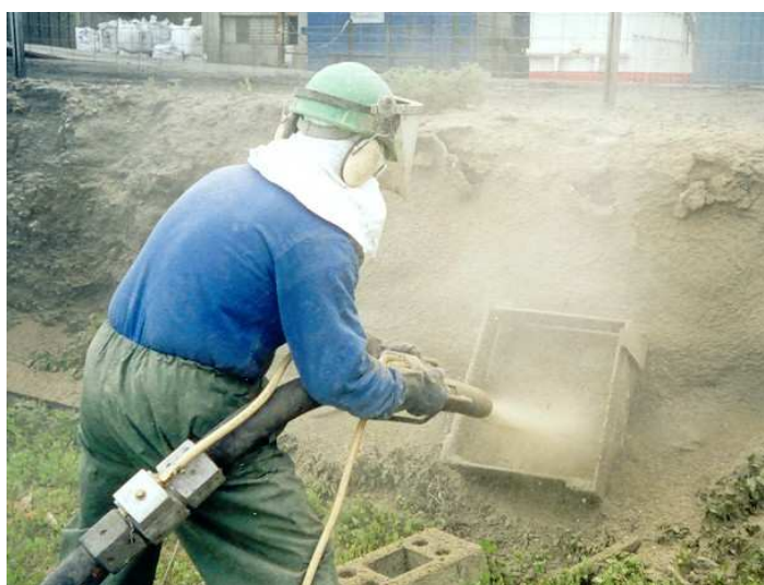
Lance de projection par voie sèche avec prémouillage
