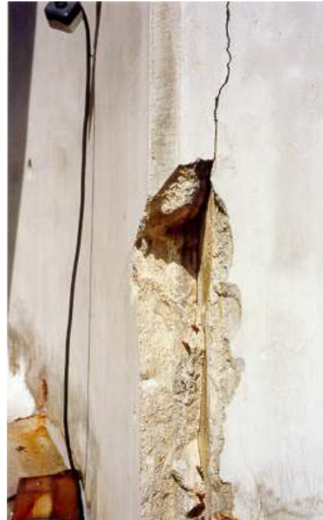
Vue générale et détail d'une rupture d'adhérence après utilisation non maîtrisée d'un promoteur d'adhérence. La résine époxy apparaît en marron sur la vue de droite.
