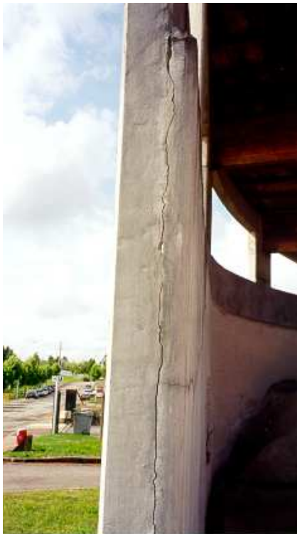
Vue générale et détail d'une rupture d'adhérence après utilisation non maîtrisée d'un promoteur d'adhérence. La résine époxy apparaît en marron sur la vue de droite.
