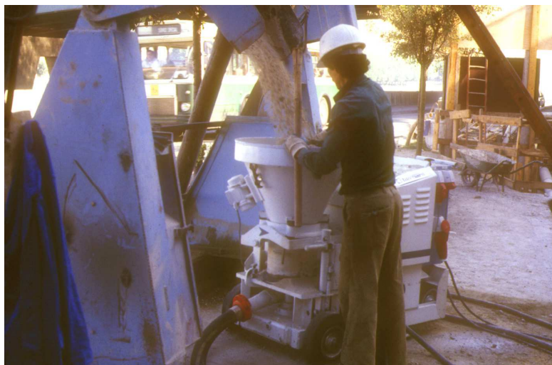
Remplissage d'une machine à rotor à partir d'une trémie de stockage
