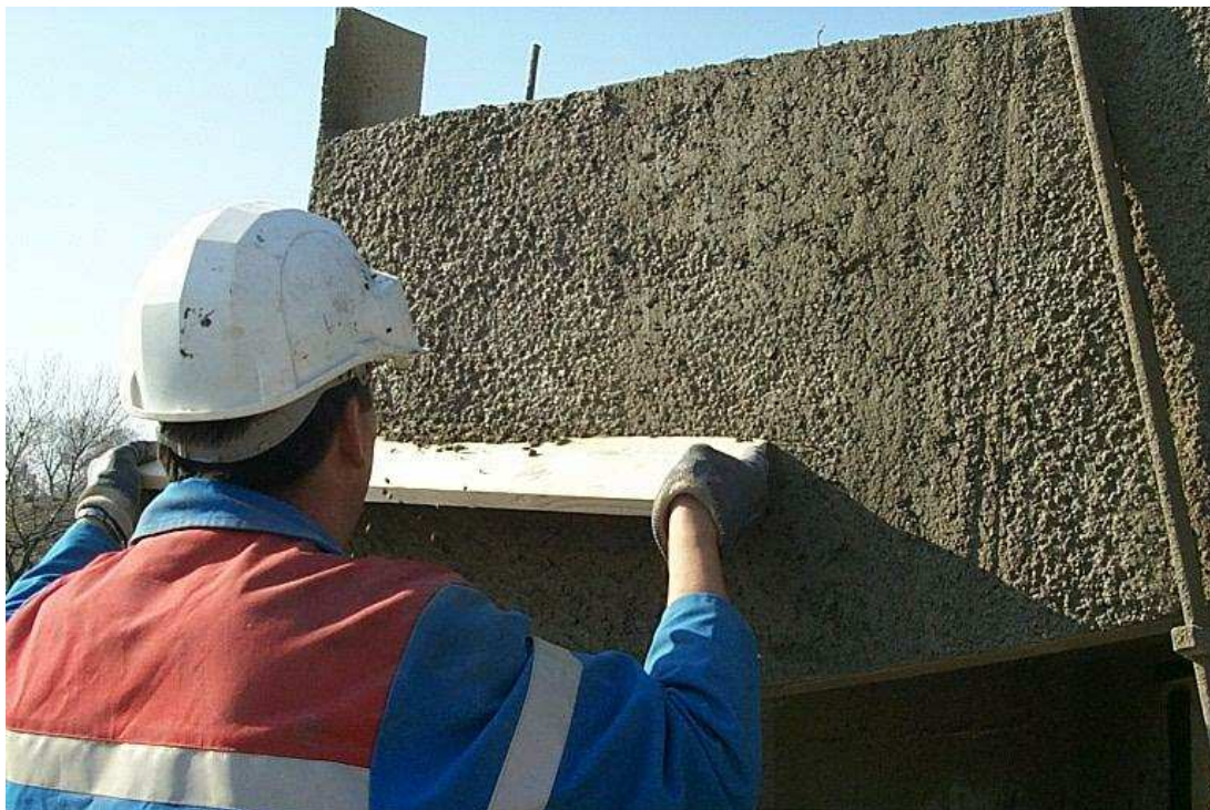
Dressement de surface par recoupe à la règle (toujours de bas en haut)
