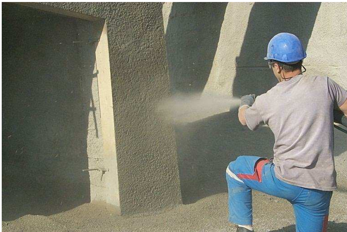
Projection d'une couche de finition centimétrique
