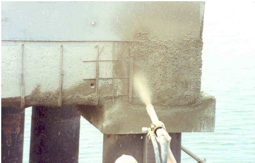
Renforcement de l'estacade du port de la ROCHELLE Début de projection par voie sèche sur support vertical
