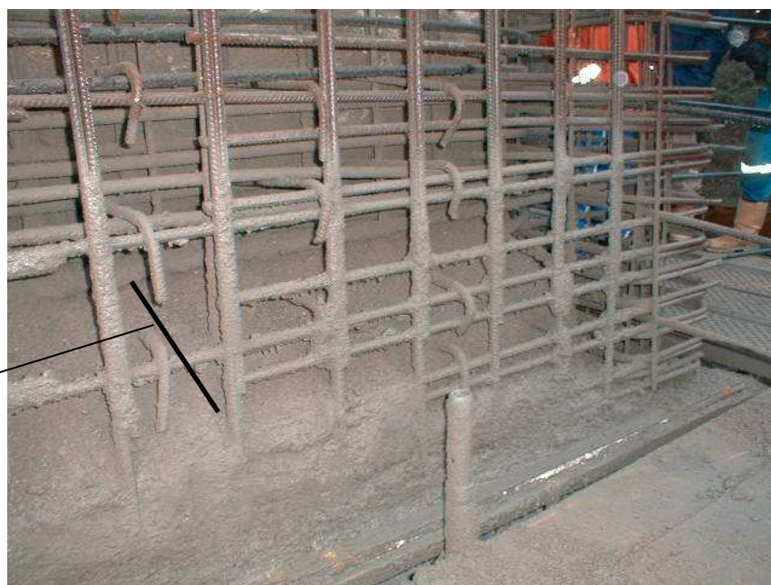
Ceinture en béton projeté armé et précontraint du viaduc de Terenez Projection en forte épaisseur (50 cm) On remarque le chanfrein dans toute l'épaisseur de la couche.
