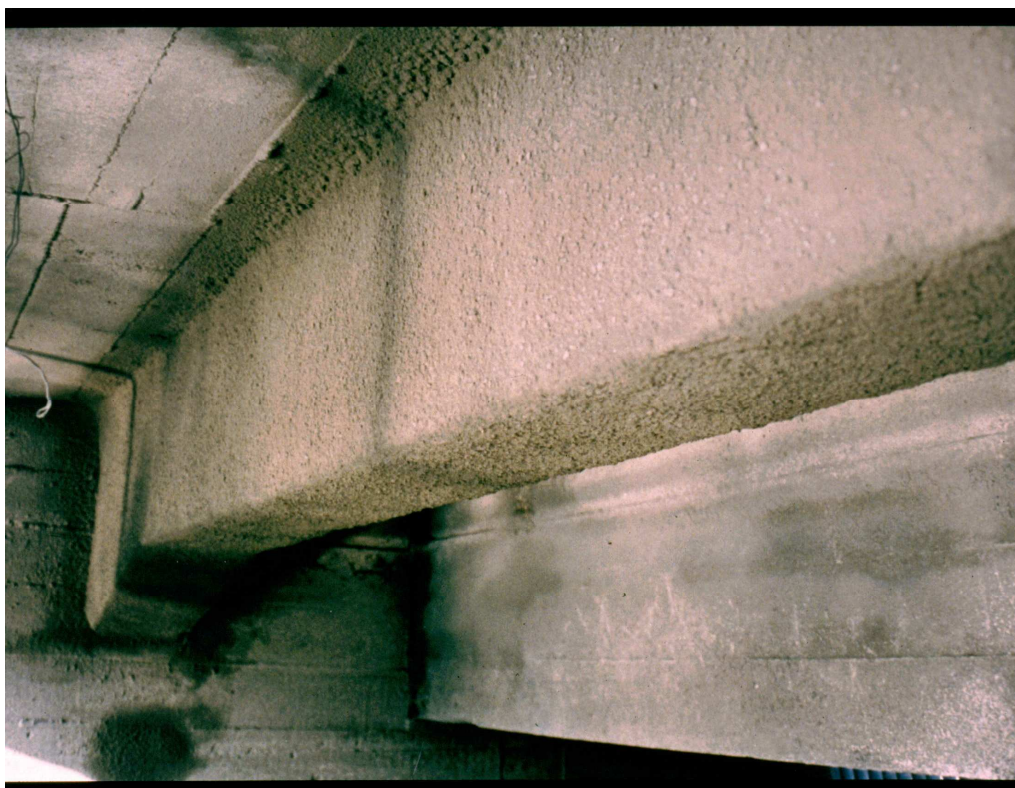
Finition dressée brute de projection
