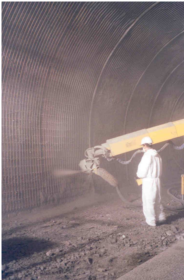
Exemple de projection avec bras manipulateur La perpendicularité du jet et la distance à la paroi sont bien respectées. (tunnel de l'Ave Maria à BOULOGNE)
