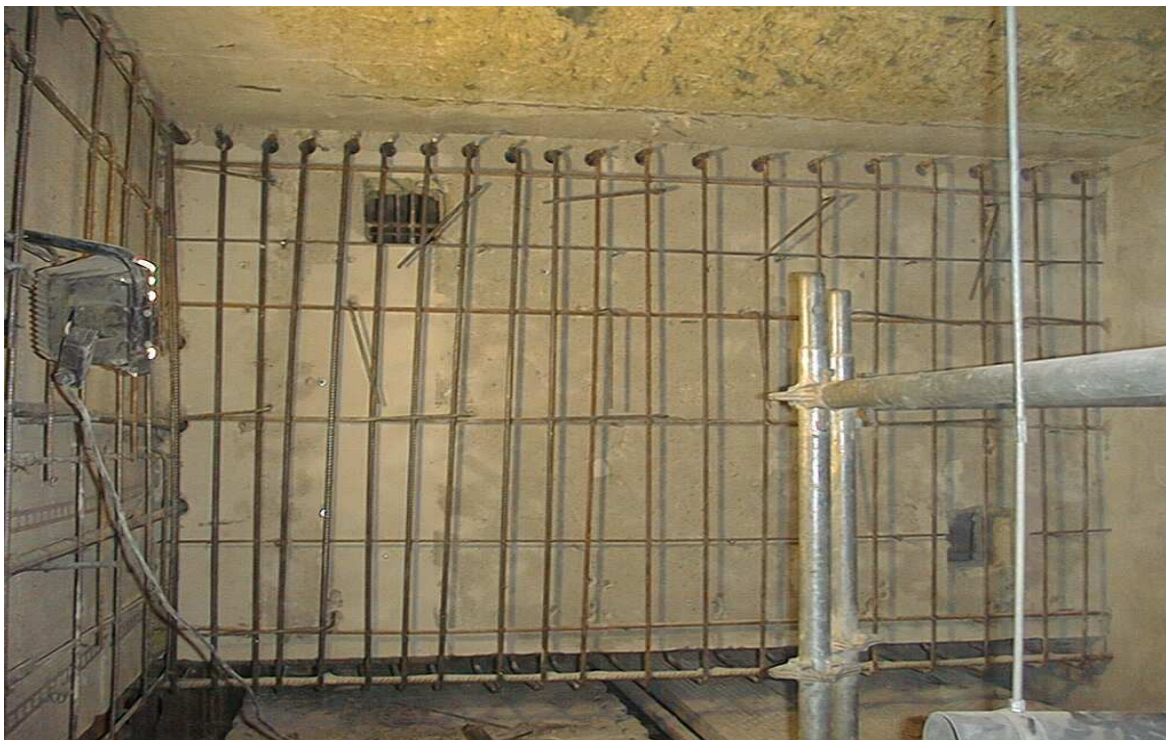
Vue du ferrailage
