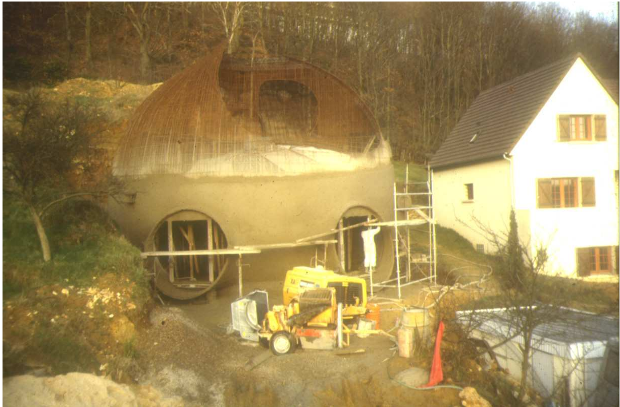
Maison sphérique à Orsay, Architecte : Mme Claude HAUSERMANN (en cours de projection par voie mouillée)
