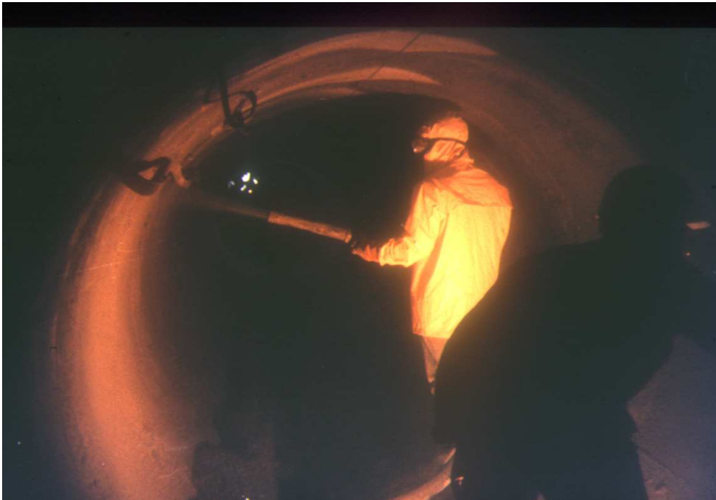
Remplissage de joints entre voussoirs en fonte pour améliorer l'écoulement des fluides dans l'aqueduc de la Vanne. (projection par voie sèche à 560 m de la machine)
