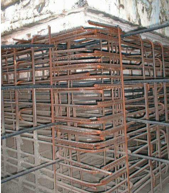
Viaduc de Terenez : réalisation d'un « corset » précontraint autour d'une pile de pont fissurée par alcali-réaction, avec barres de clouage le liant à la maçonnerie
