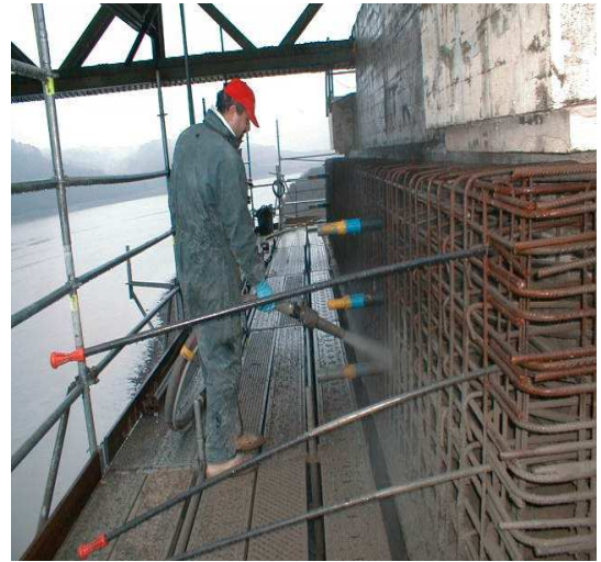
Viaduc de Terenez : réalisation d'un « corset » précontraint autour d'une pile de pont fissurée par alcali-réaction, avec barres de clouage le liant à la maçonnerie
