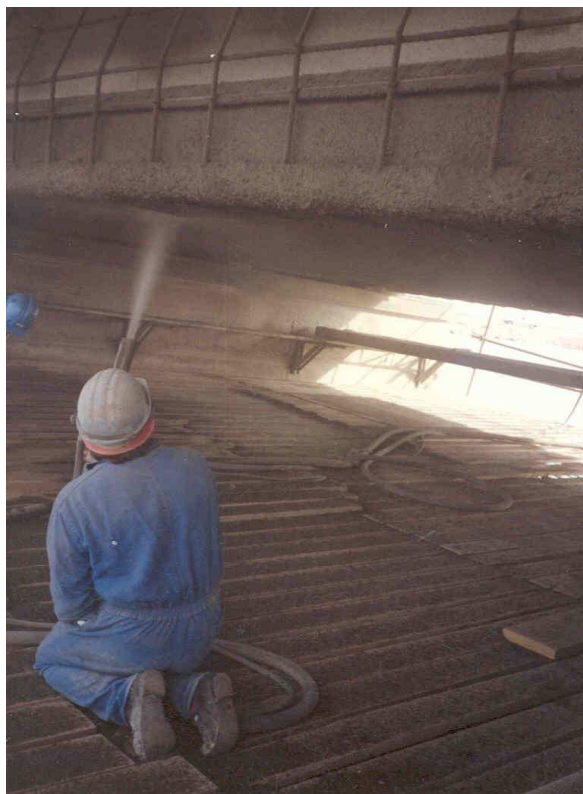
Augmentation du niveau de service d'un pont
