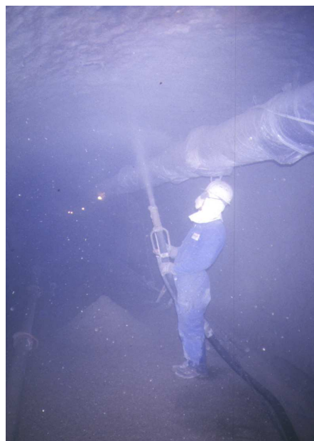
Chemisage complet pour le renforcement d'un égout parisien
