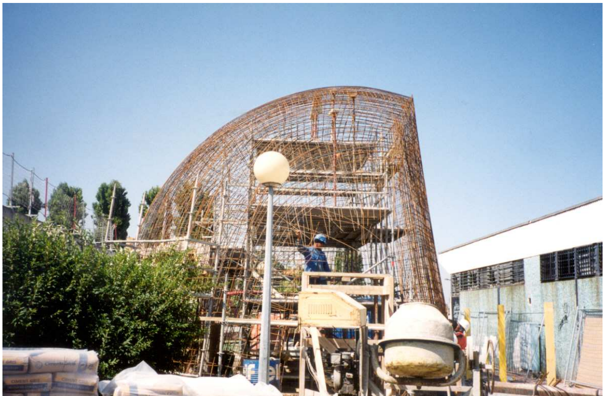
Salle polyvalente de Goussainville : « Le Pouce » Projection par voie sèche depuis l'intérieur sur coffrage extérieur en contreplaqué
