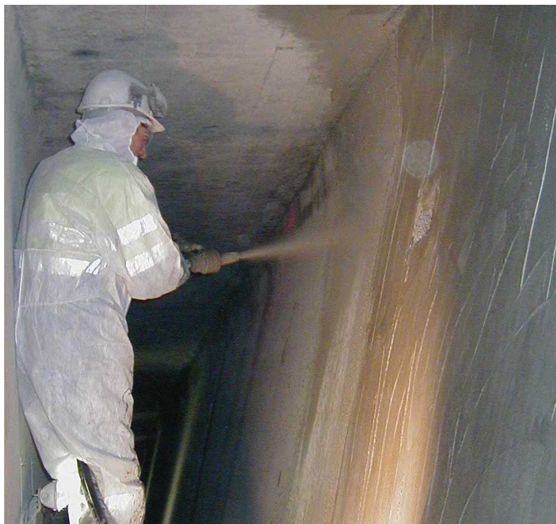
Projection par voie mouillée sur les piédroits dégradés par le gel dans les gaines de ventilation du tunnel sous le Mont Blanc.
