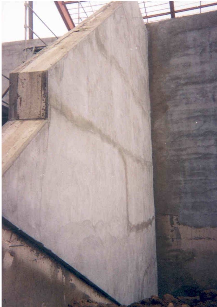
Aspect fini d'un voile en béton renforcé par projection ( finition talochée, tolérance de planimétrie de \pm 5\text{mm} sous la règle de 2 m) On remarque les différences de teinte difficilement évitables au niveau des reprises de bétonnage
