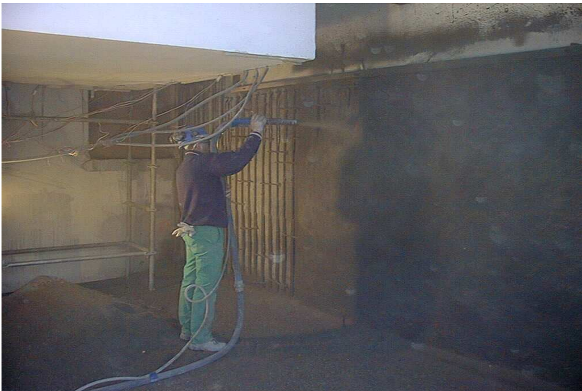
Vue de la projection du renforcement de 10 cm d'épaisseur avec une forte densité d'armatures (2 nappes d'acier mises en place au fur et à mesure de la projection ; finition lissée permettant une mise en peinture directe)
