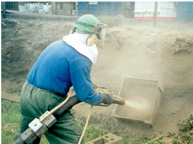
Lance voie sèche avec prémouillage
